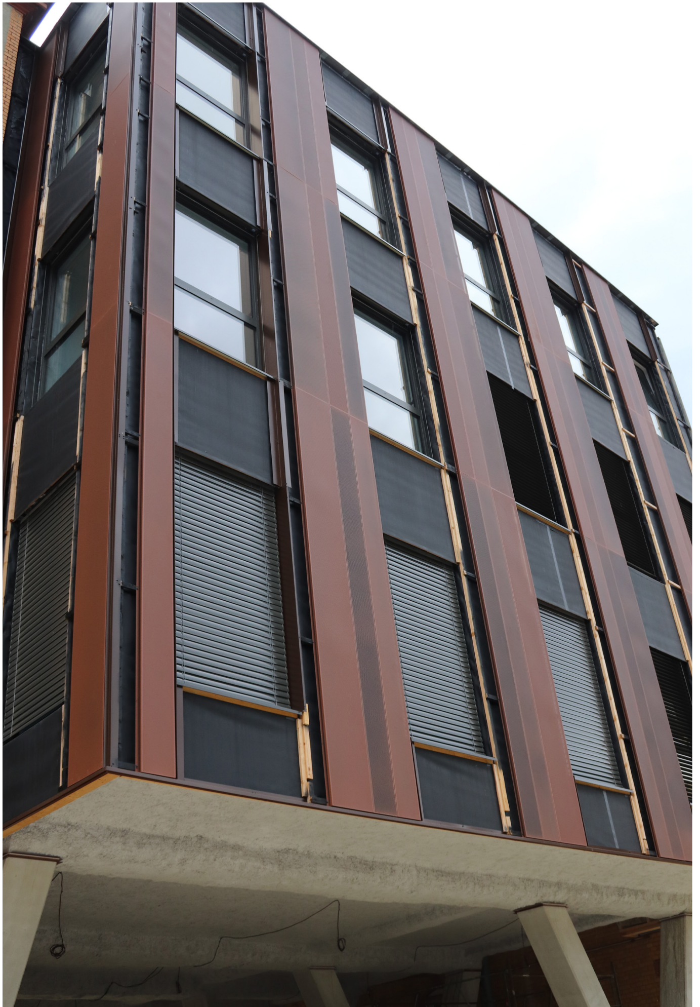
L'un des nouveaux bâtiments de la cité administrative de Colmar en septembre 2022
